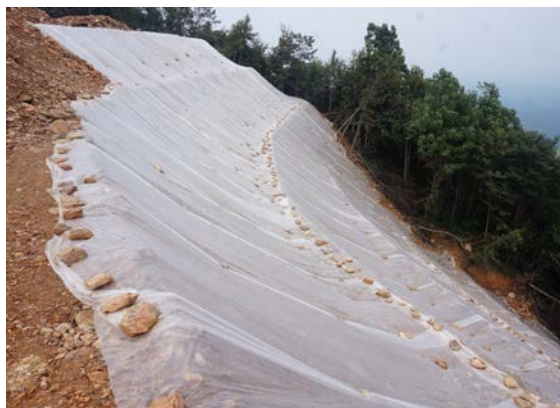
照片 4.3-3 场内道路临时覆盖
