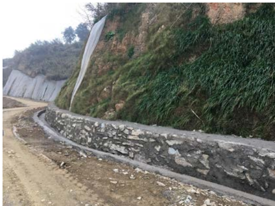
照片 4.1-10 道路内侧浆砌石挡墙
