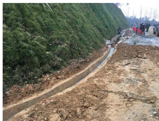
工程措施实施过程现场监测
