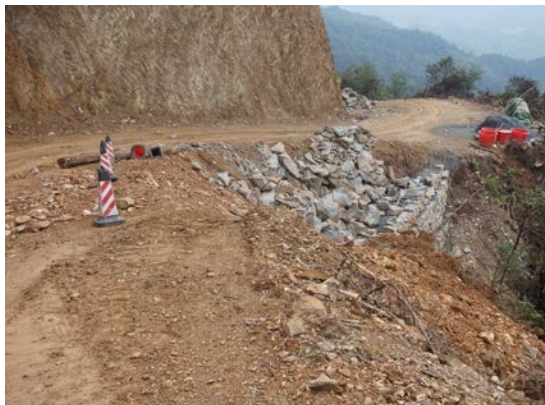
照片 4.1-1 道路外侧浆砌石挡墙
