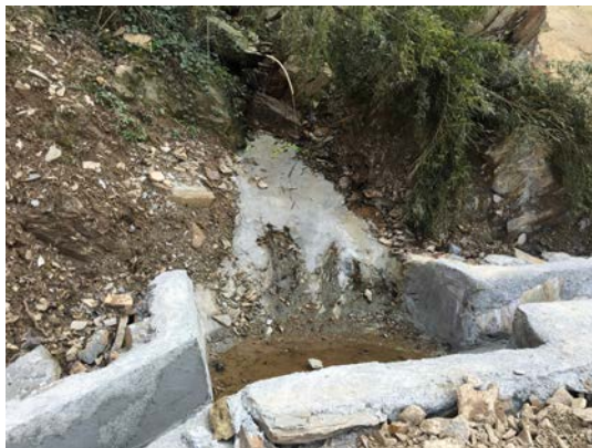
照片 4.1-12 场内道路沉沙池
