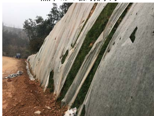
照片 4.3-6 场内道路临时覆盖
