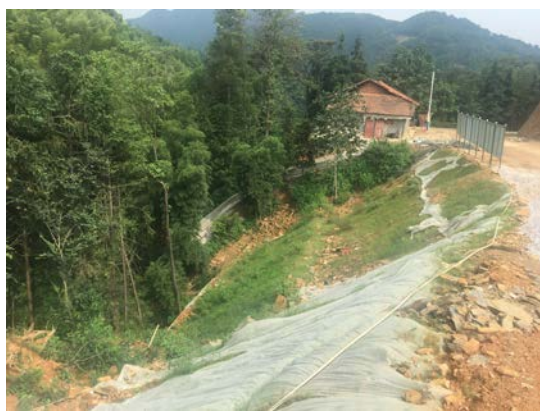
照片4.2-1 进场道路边坡撒播草籽
