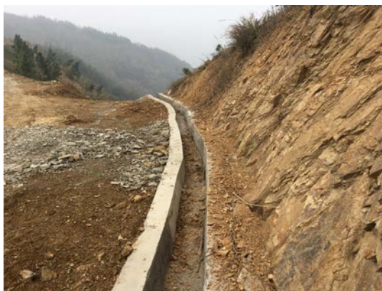
照片 4.1-4 场内道路预制混凝土排水沟
