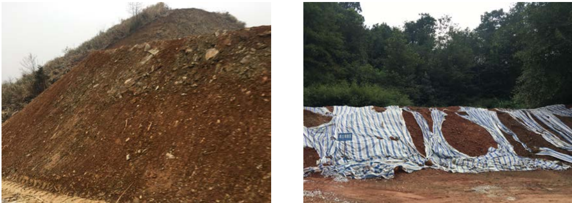
照片 2.2.3-2 简易坡面量测场
