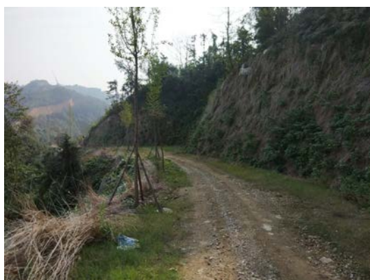
照片4.2-15 场内道路栽植乔木
