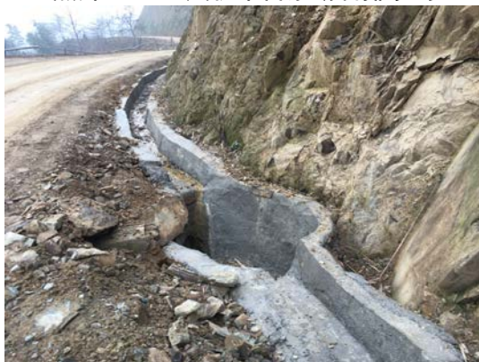
照片 4.1-8 场内道路沉砂池
