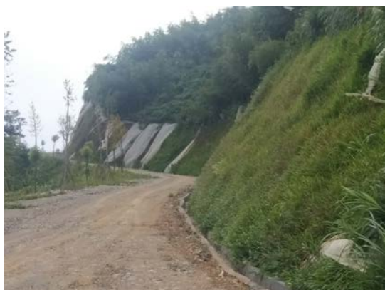
照片4.2-7 场内道路喷播植草
