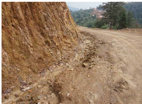
照片 4.3-4 临时排水沟
