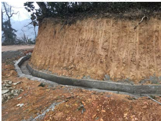
照片 4.1-7 道路预制混凝土排水沟
