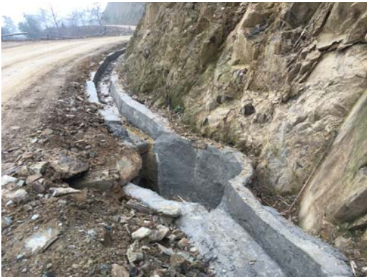
工程措施现场抽查
