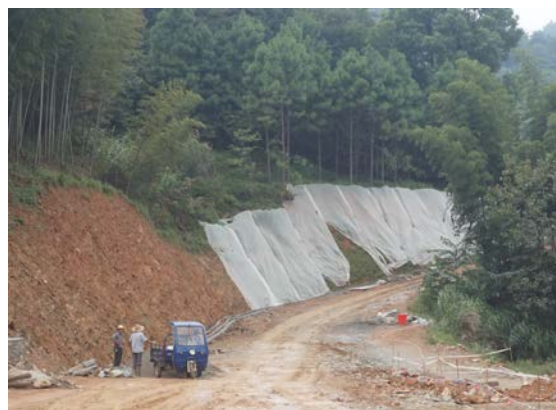
照片 4.3-2 进场道路临时覆盖
