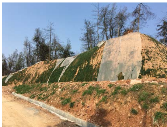
照片4.2-3 场内道路喷播植草
