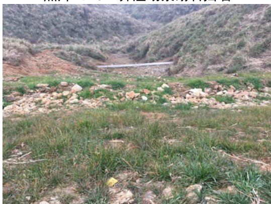
照片 4.1-5 弃渣场浆砌石挡墙
