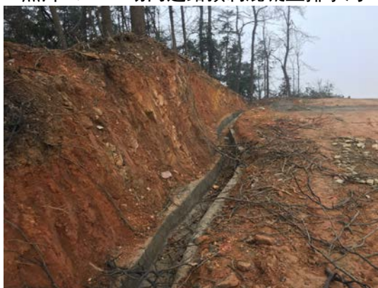
照片 4.1-6 风机平台浆砌石排水沟
