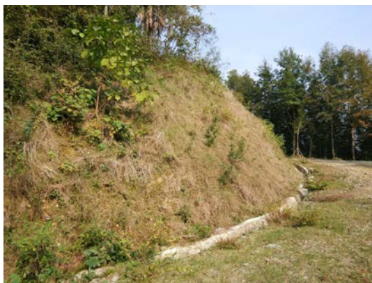
照片4.2-12 场内道路喷播植草
