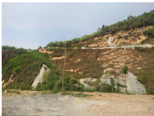
照片4.2-9 场内道路喷播植草
