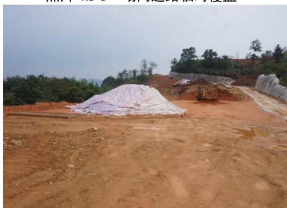
照片 4.3-5 表土临时覆盖
