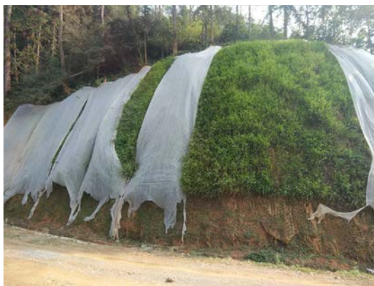
照片4.2-14 场内道路挂网喷播
