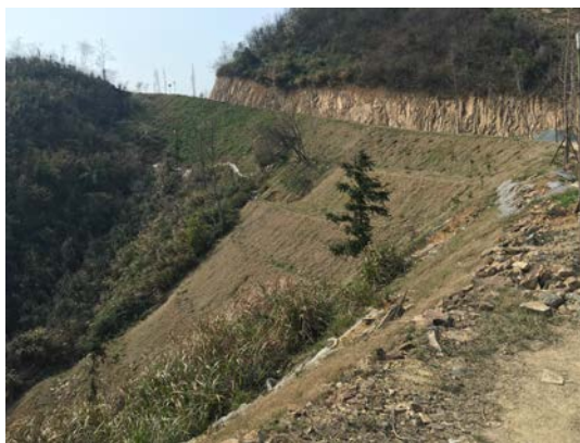
照片4.2-6 进场道路边坡撒播草籽
