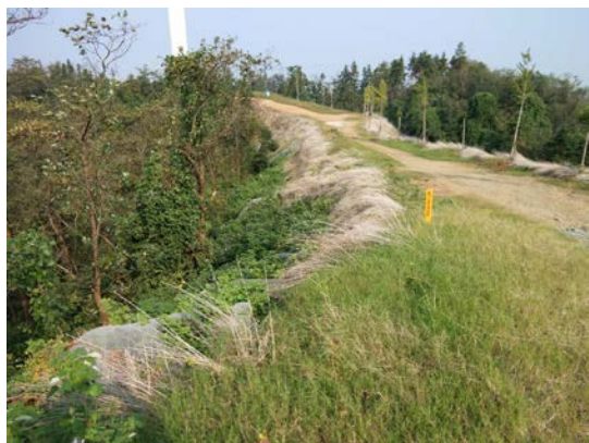
照片4.2-11 场内道路栽植乔木
