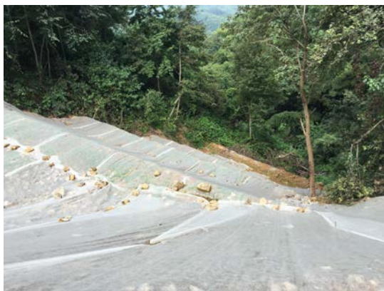
照片 4.1-3 弃渣场浆砌石挡墙
